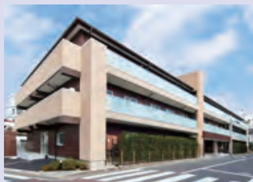
有料老人ホーム「グランダム摩川・大田」。外壁は施工後も着脱可能でメンテナンス性も高い
